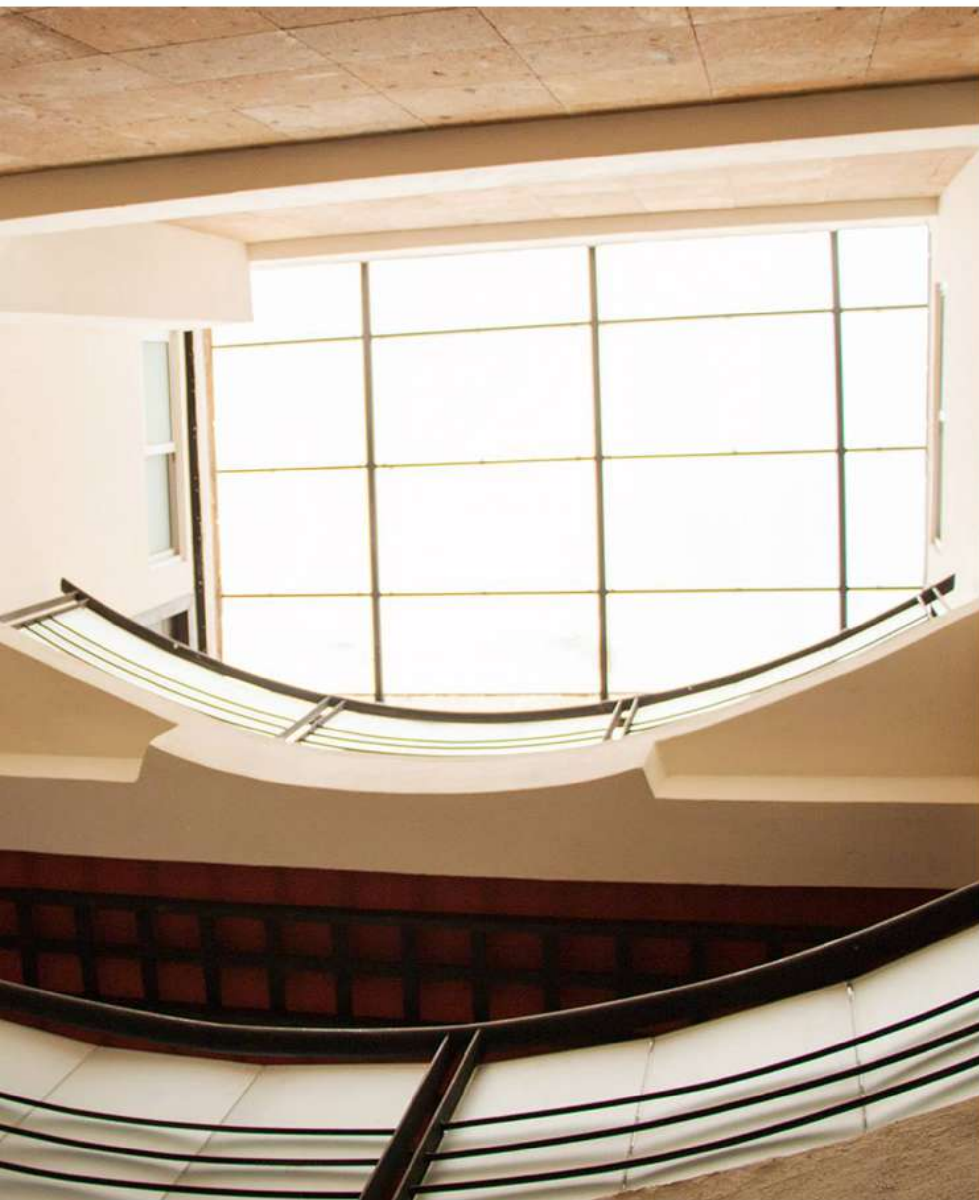
Paneles solares. Bioclimática, edificio de bajo consume energético. Iluminación LED.
