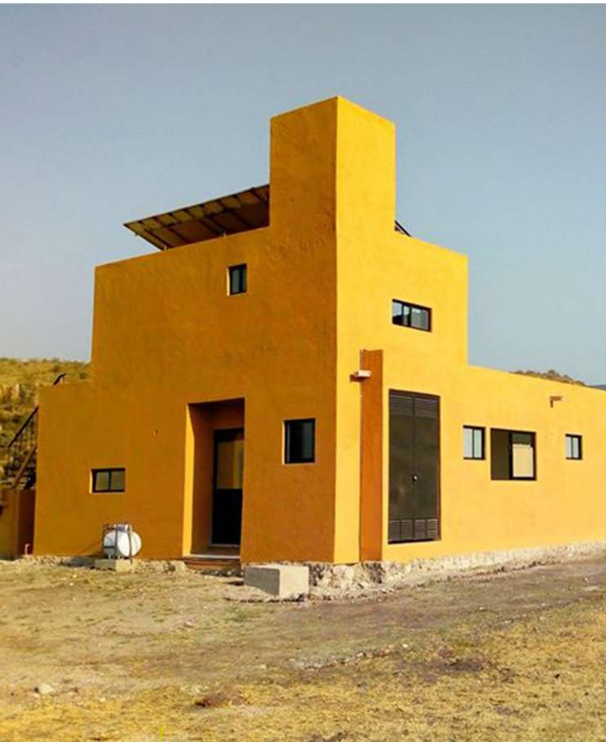
Paneles solares, captación de aguas, biodigestor, calentador solar, iluminación Led.
